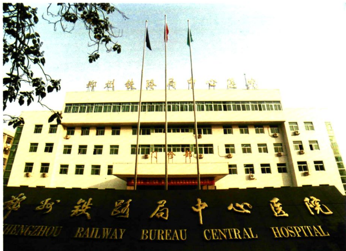
建成于1998年设备先进功能齐全的酒店门诊大楼
