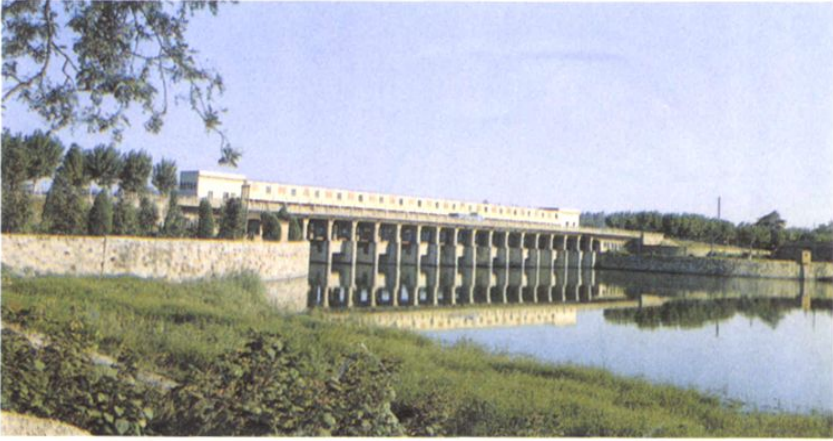
中运河泗阳节制闸
