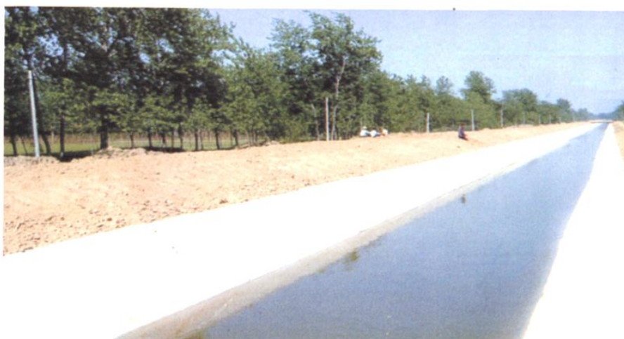
防渗渠道（八集支架）
