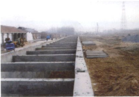
竹络坝干渠输水明渠
