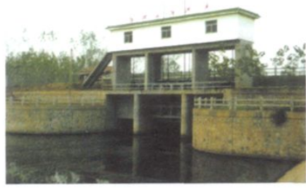
淮泗河挡洪闸
