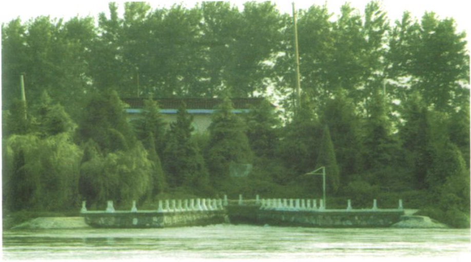
中运河西门渠首闸
