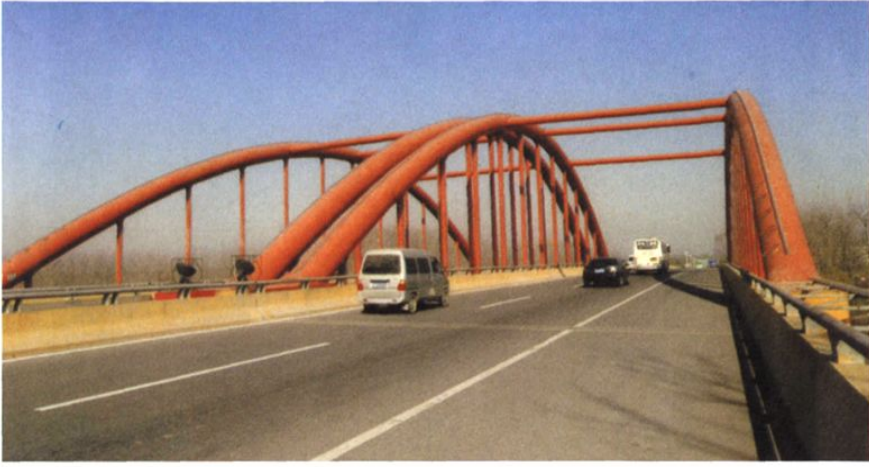
京杭运河泗阳二桥
