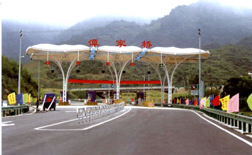
合铜黄高速公路谭家桥出口
