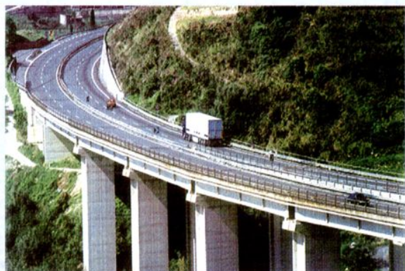
合铜黄高速公路高架桥
