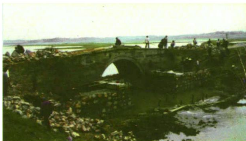
正在改建的古桥——宋兴桥施工工地
