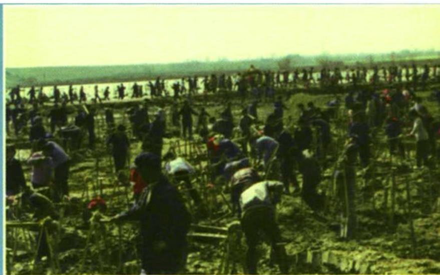
图为湾石公路石碓段民工挑筑公路工地
