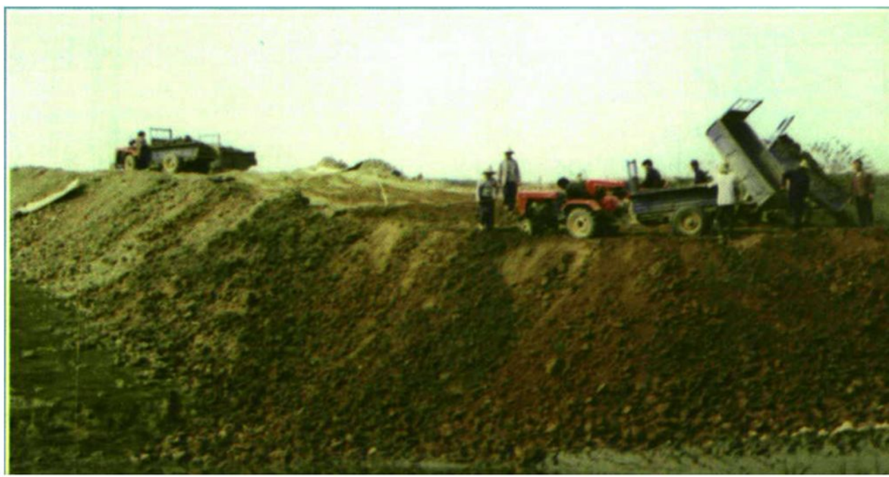
图为荆山至十连公路陶辛段和尚桥桥头施工场地
