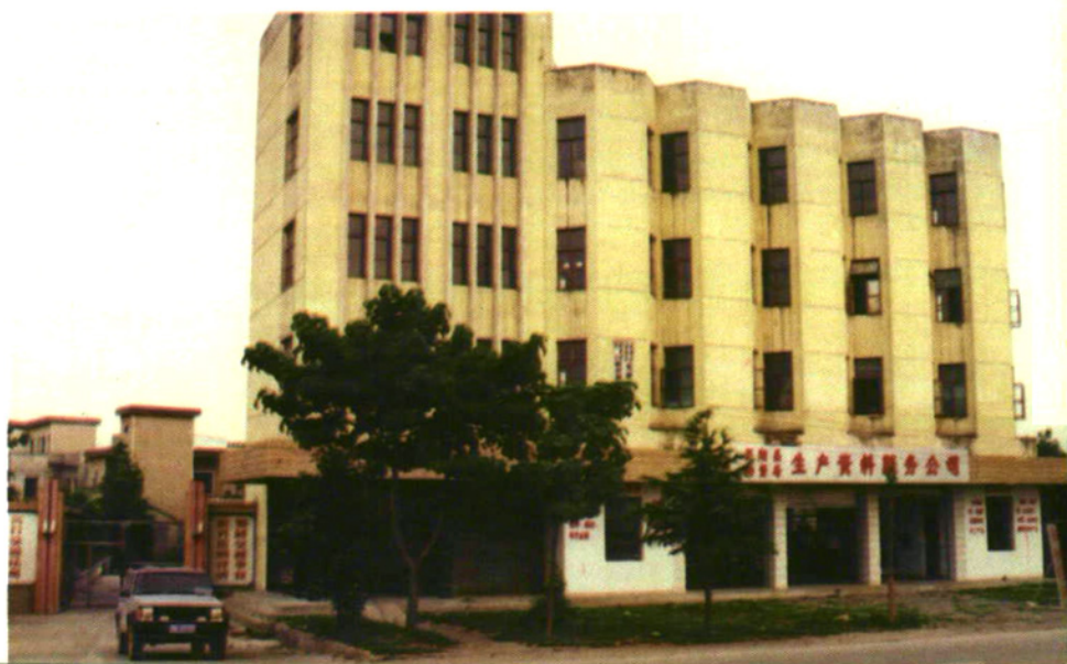
图为鲁港交管站办公大楼
