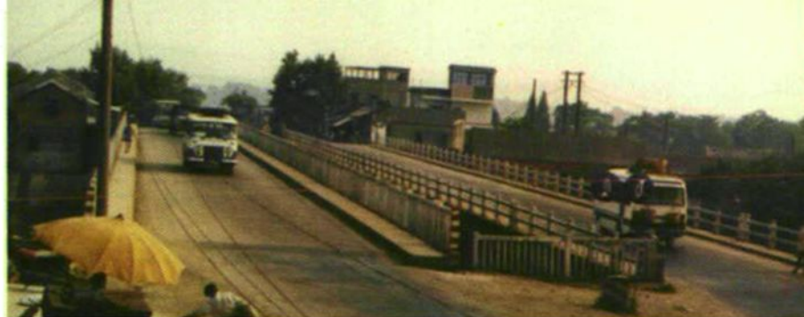
图为芜屯路上的清水河双桥
