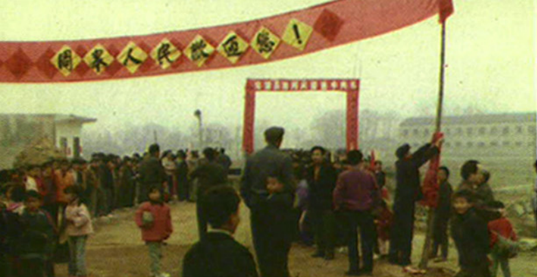
图为济沭至周村乡公路通车盛况
