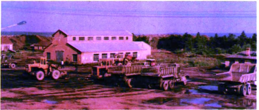
煤矿机修车间
