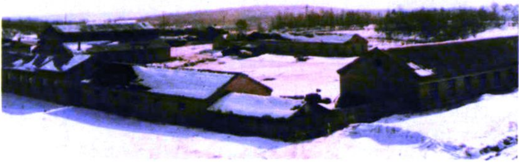
煤矿机修与服务设施
