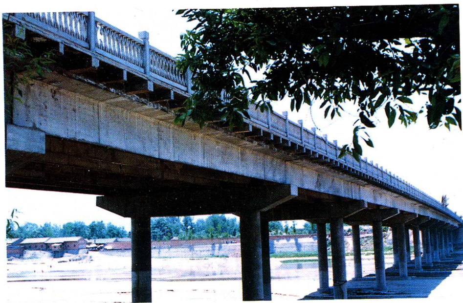
秦渡镇洋河大桥
