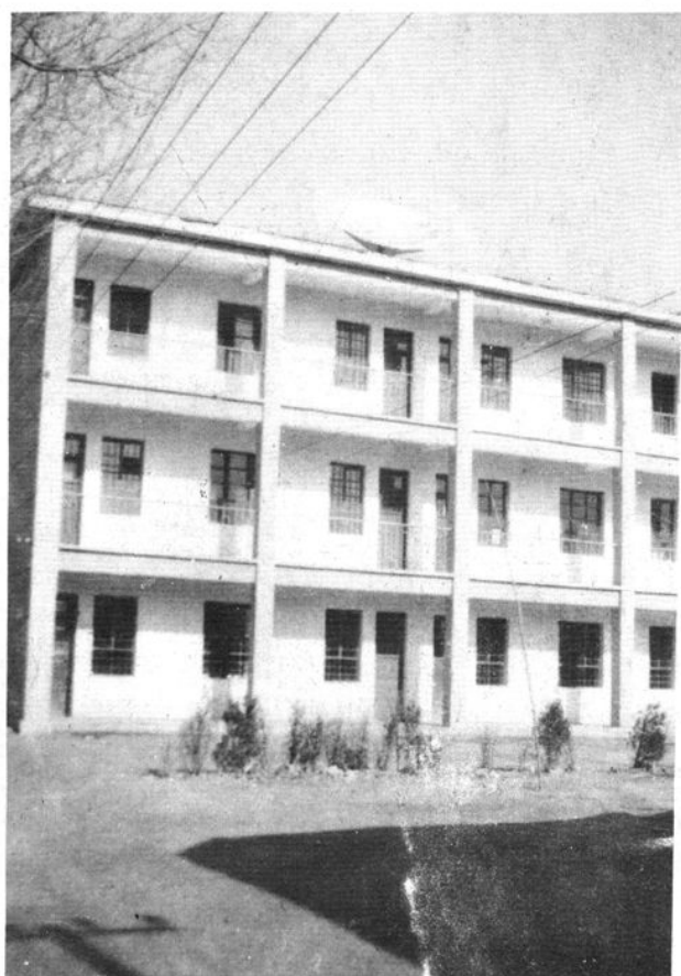
聊城第一职业中专教学大楼之一角
