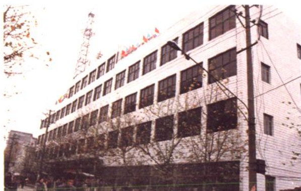
进贤县邮电局邮电综合大楼
