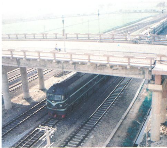
△京廣鐵路新街火車站鐵路立體交通
