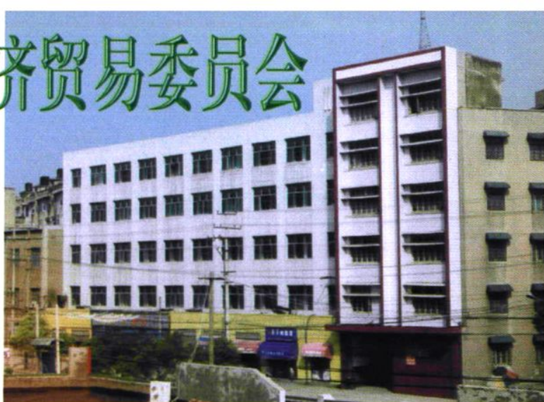
市外经委办公楼外景
