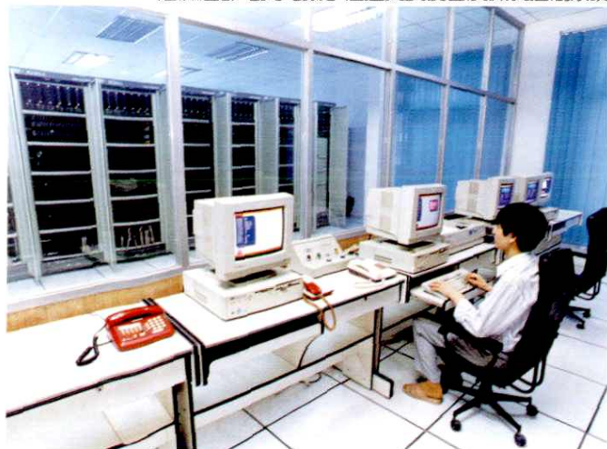
泗洲庙邮电支局数字程控交换设备及微机控制系统
