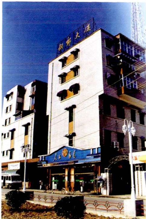
江西省第二大邮电支局—德兴市泗洲庙邮电支局通信大楼
