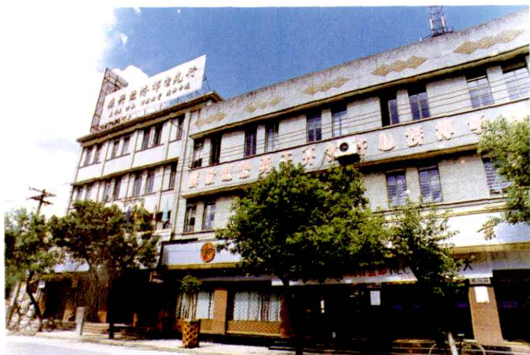
市局邮电通信综合大楼
