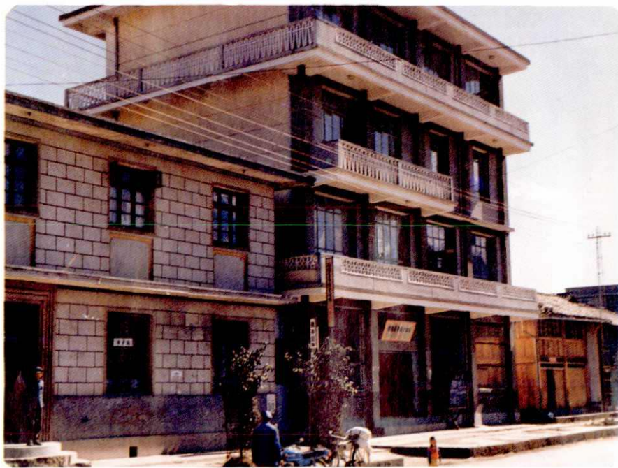
腾冲县轻工业局大楼
