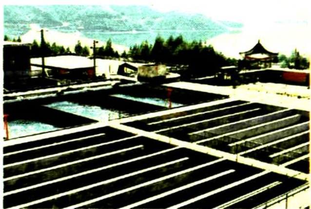
信阳市水厂气浮池
