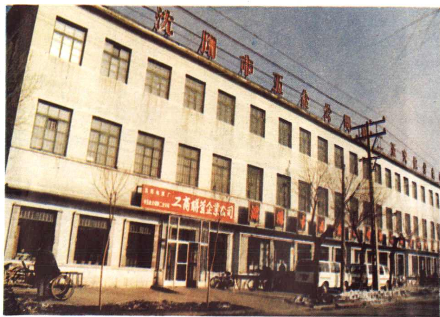
第二五交化分公司营业楼外貌
