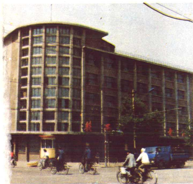
第一五交化分公司营业楼
