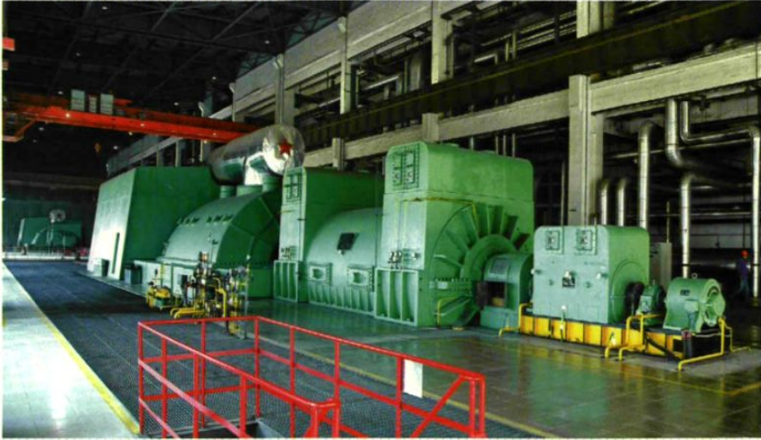
大唐安阳发电厂 30万发电机组
