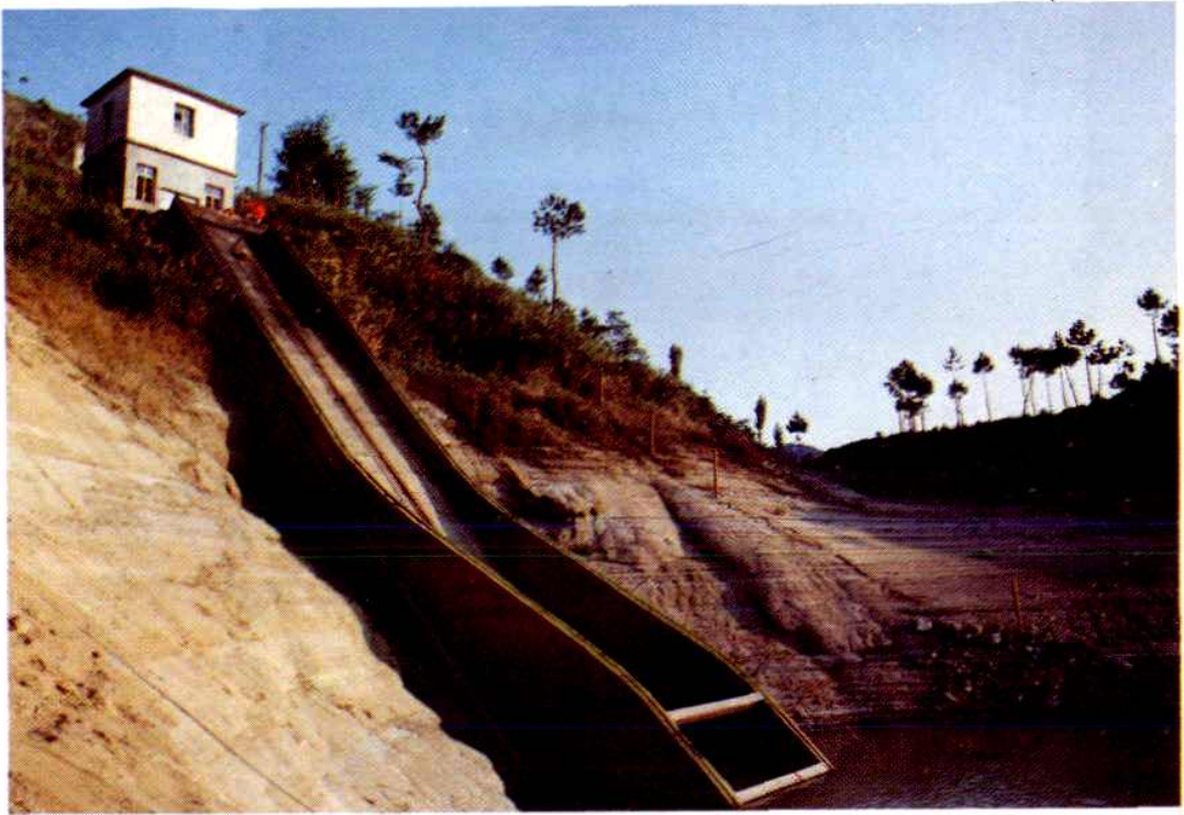
发电隧洞进口
