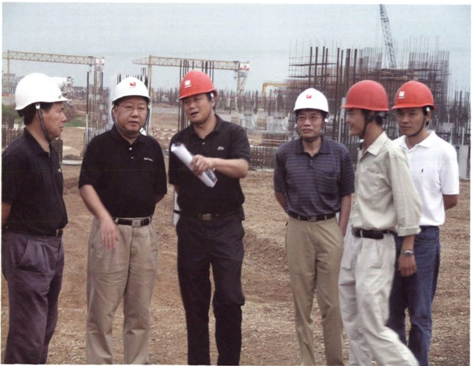
● 2004年9月18日，浙江省人大常委会常委、省电力公司党组书记陈积民（左二），电监会杭州监管办专员谢国兴（左一）在金华电业局局长程极盛（右三）的陪同下到兰溪检查浙能兰溪电厂建设工作
