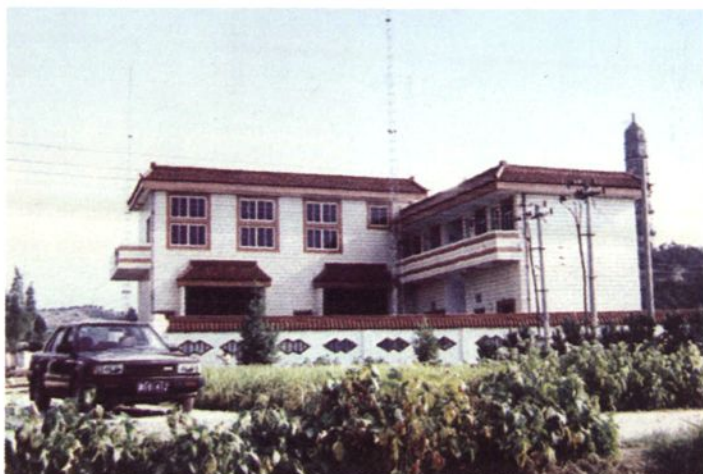
● 兰溪市电网第一座综合自动化 35 千伏变电所——香溪变电所
