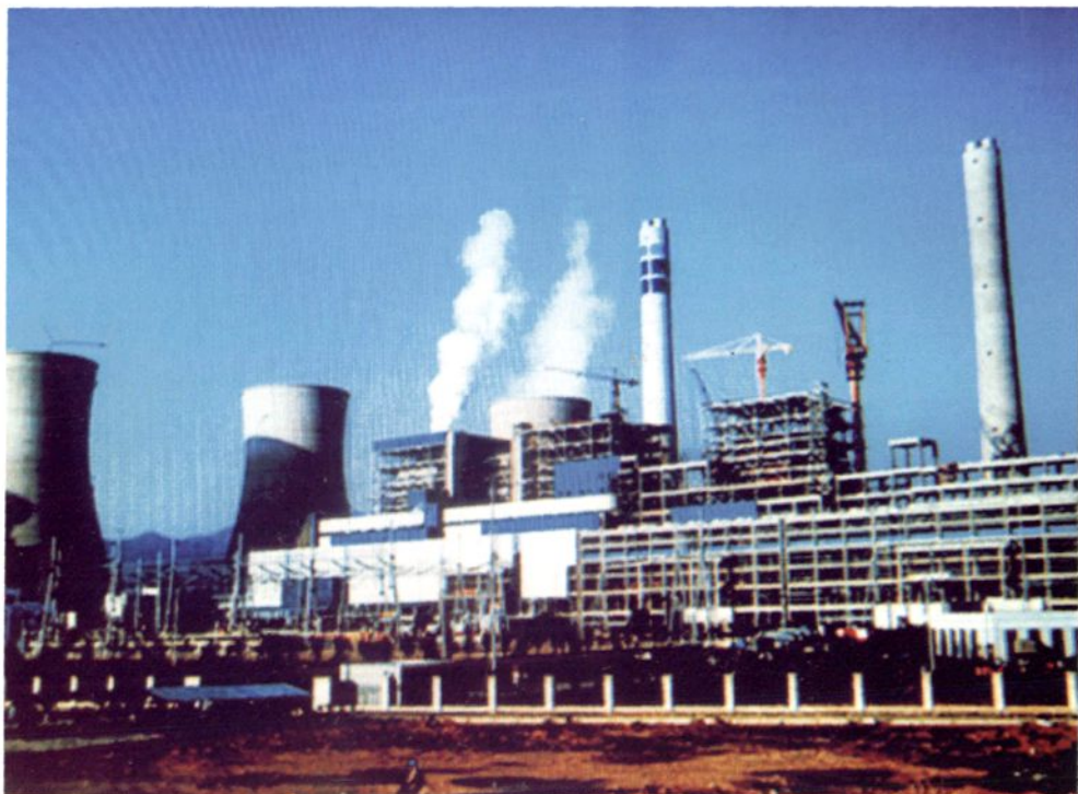
● 2003年开始建设的浙能兰溪电厂全景
