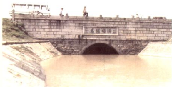
茂林暗涵出口(即东瑶暗涵)
