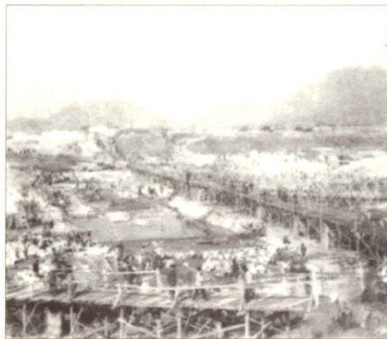
拦河闸枢纽施工场景
