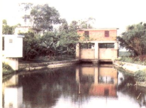
左干渠龙屿节制闸
