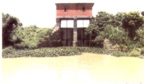
右干渠进水闸
