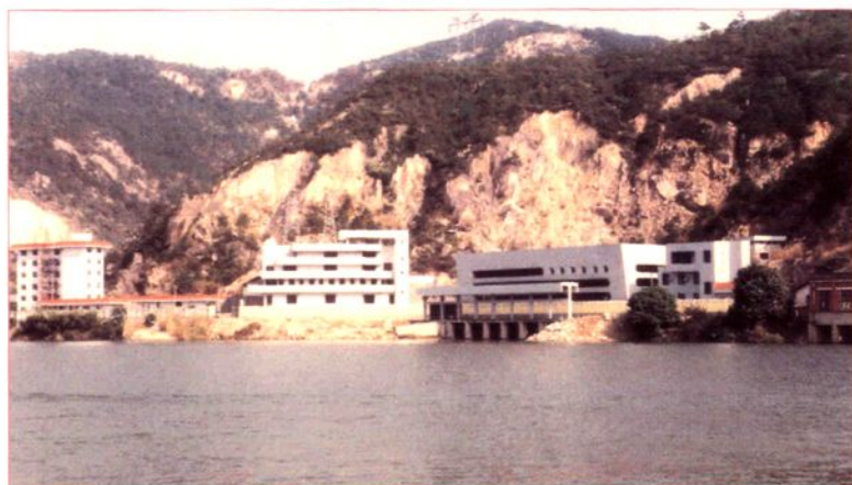
厦门管道供水工程(江东泵站)与左干渠互为备用
