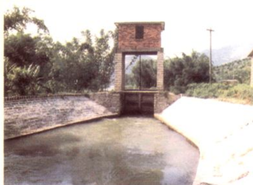
普西低干渠分水闸
