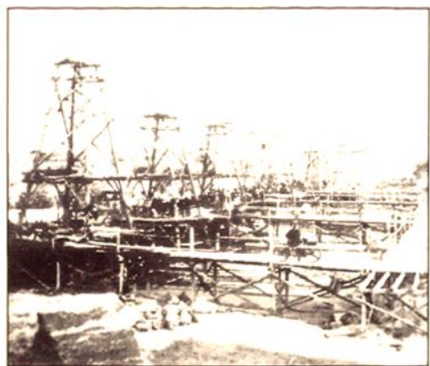
闸基井柱桩施工布置
