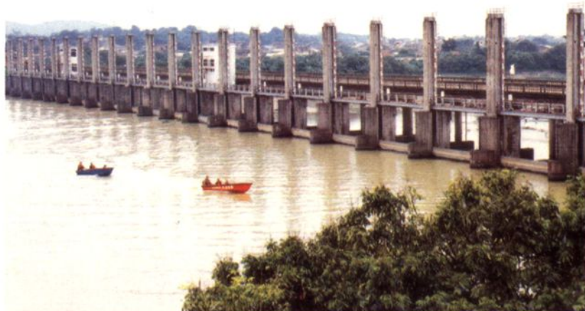
宏伟的 25 孔北港桥闸 长 293 米
