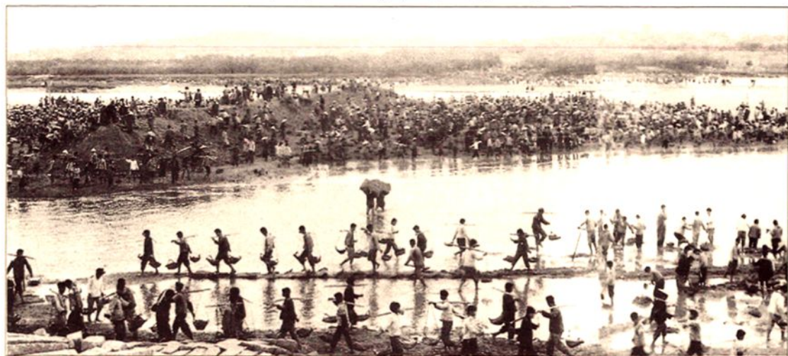
会战北港桥闸 施工场面壮观(1975.12)
