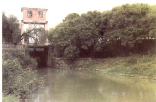
中干渠进水闸
