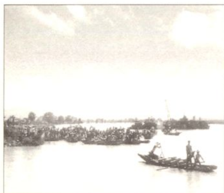
百舟竞发齐锁蛟龙(南港导流围堰施工)
