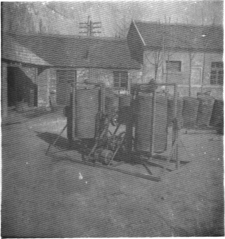
县自制洗桶机，全国定型为HZ—2型
