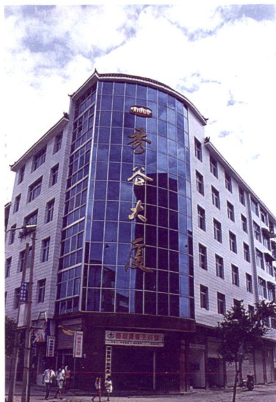
秀谷大厦四号楼(1999年)
