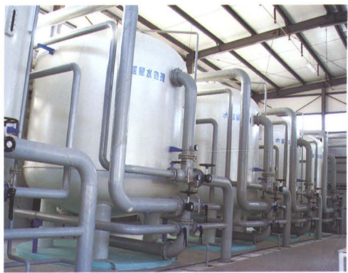
450 立方米 / 小时污水回用装置
