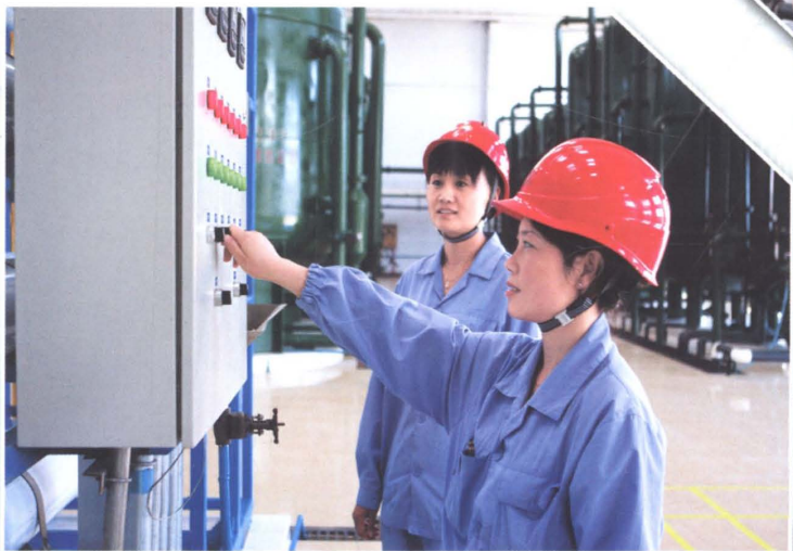
工业水车间员工在进行日常巡检操作
