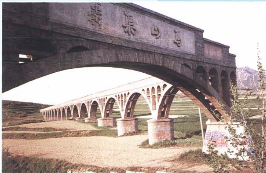
马山渠渡槽全长310米，共分21孔
