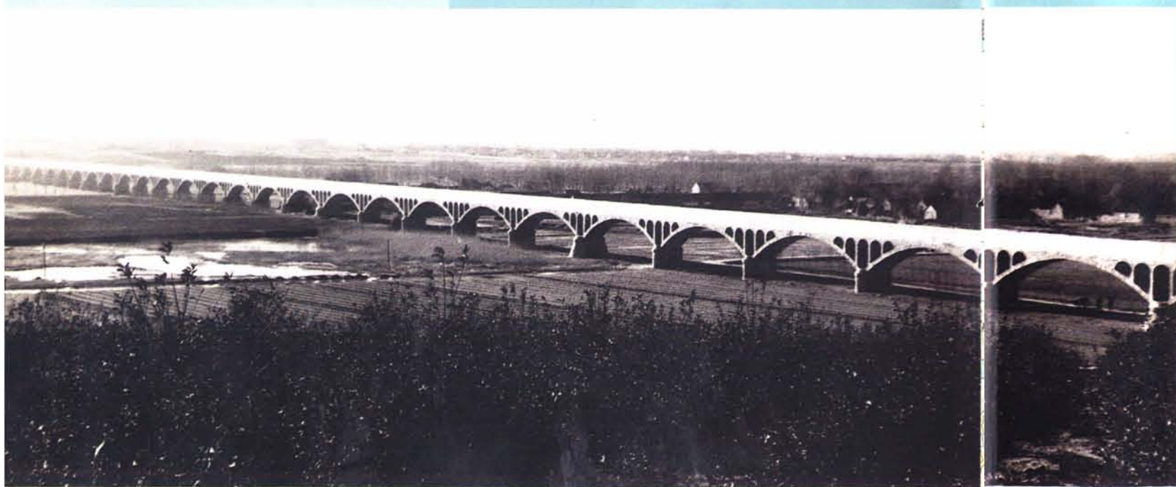
米山水库东干渠的迎春渡槽，全长507米，共分37孔
