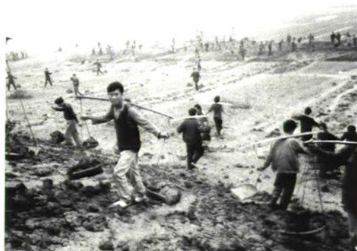
阳新县组织劳力加固网湖堤防（1995年）
