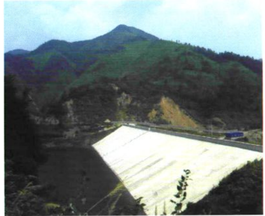
阳新县中型水库——小青山水库
