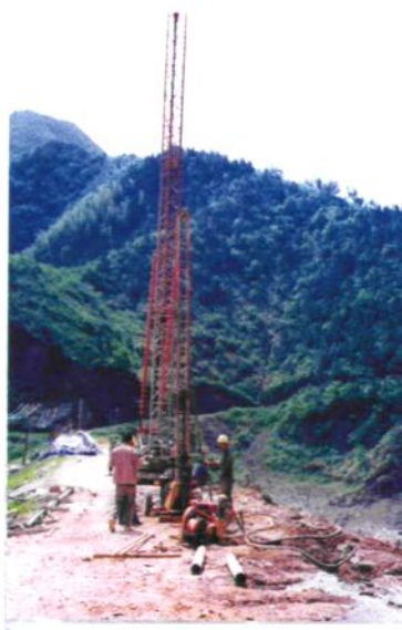
大王镇前进水库锥探灌浆（2005年）
