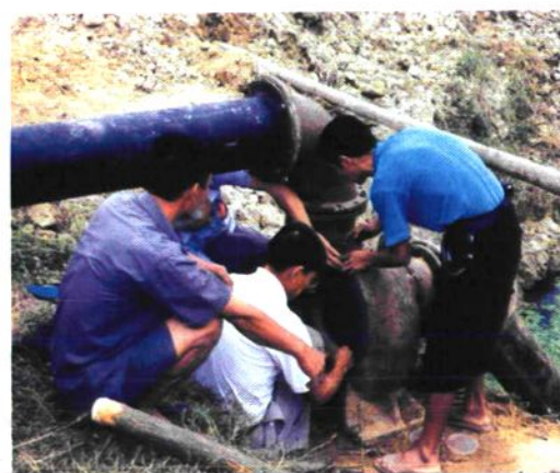
陶港镇村民安装水泵，抽水抗旱（2001年）
