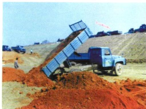
阳新长江干堤月亮湾堤段施工（1999年）
