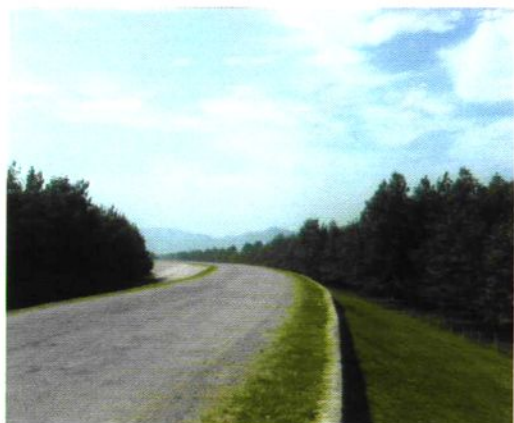
阳新长江干堤海口堤防（2005年）
