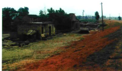
阳新长江干堤海口堤防（1998年）
