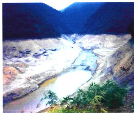
浮屠镇十八折水库干涸见底（2005年）
