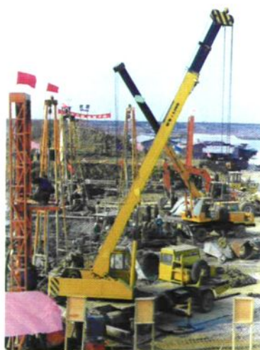
网湖分洪灭螺控制闸施工（2001年）
