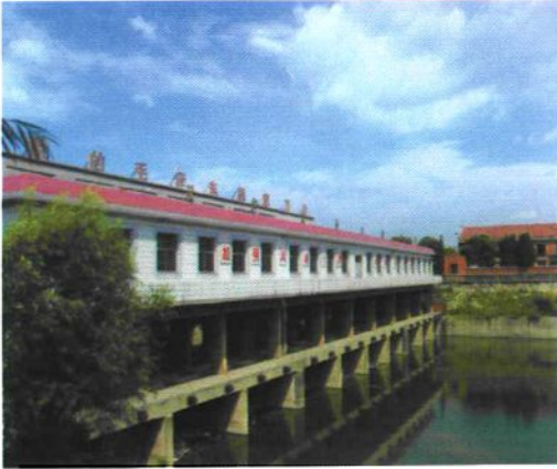
湖北省大型泵站之一——富池口电排站
