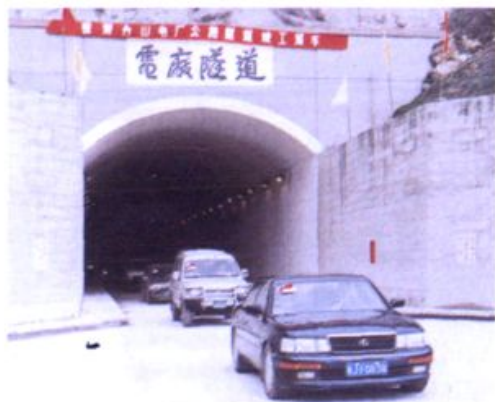
↑ 台山电厂公路隧道竣工通车。
