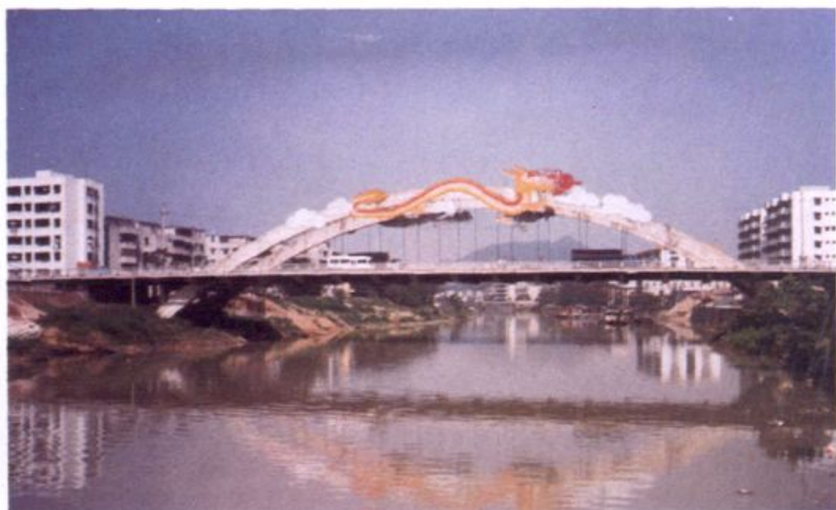
→台城过境公路新宁大桥全貌
