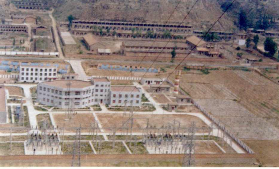
延安330千伏变电站全貌
