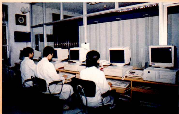
程控电话机房
