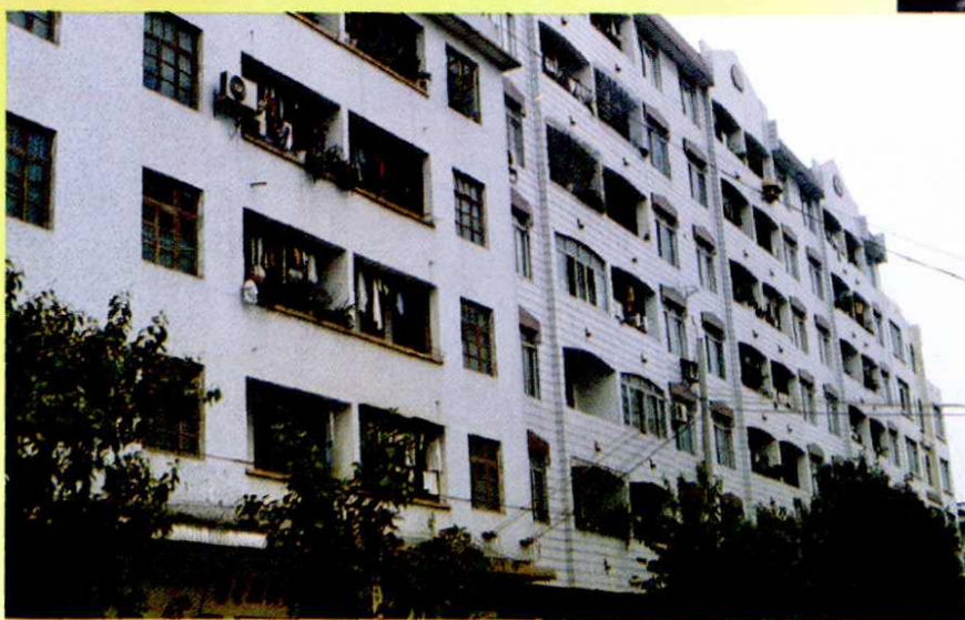
▲ 新松路邮电职工宿舍大楼。
