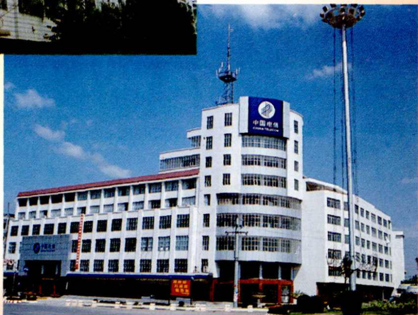
▲ 北流市电信局大楼。
