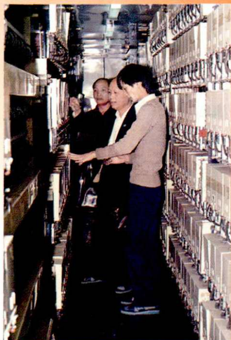
▲ 1989年12月10日开通2000门史端桥步进制自动交换机。
