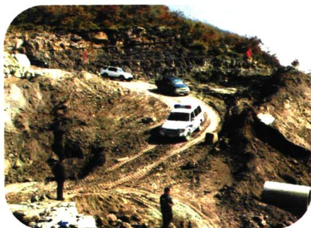
三关楼 - 底家河矿区公路施工现场
