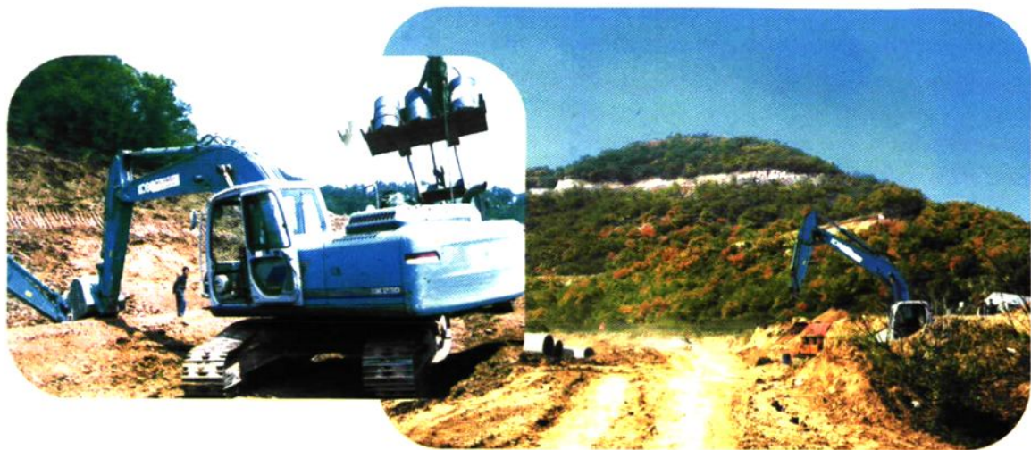
公路建设工地
