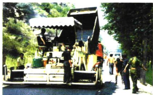
乡村油路铺设
