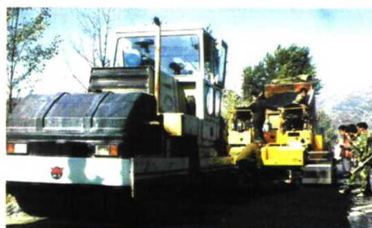
村村通油(水泥)路施工现场
