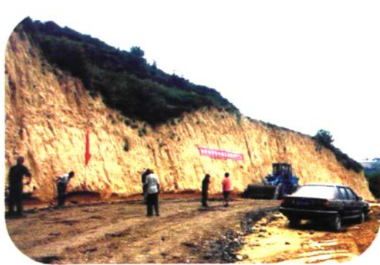
罗克公路建设
