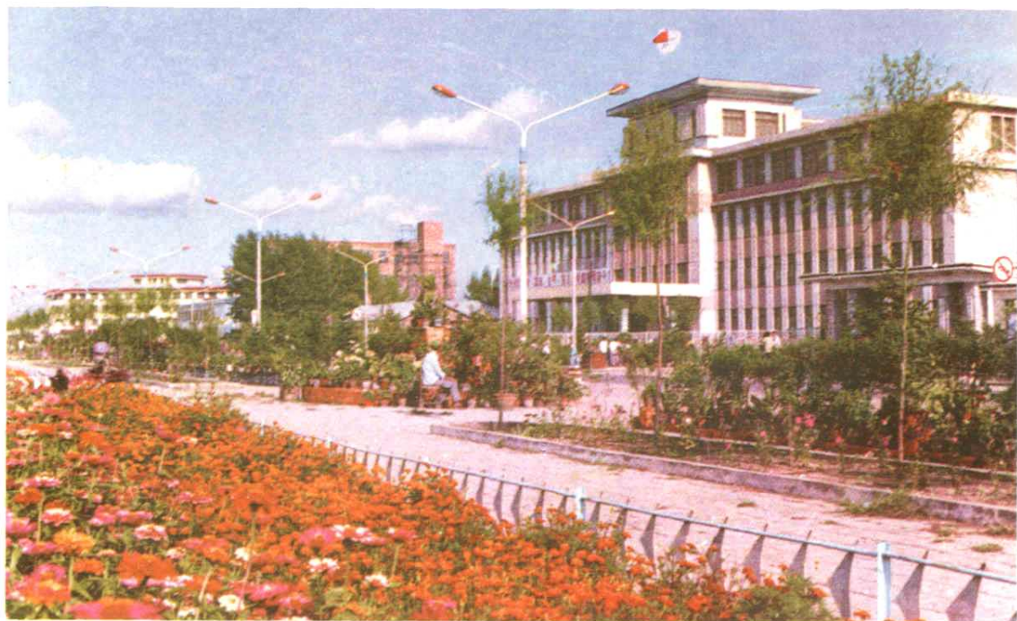
市委、市政府大楼（县志稿）
