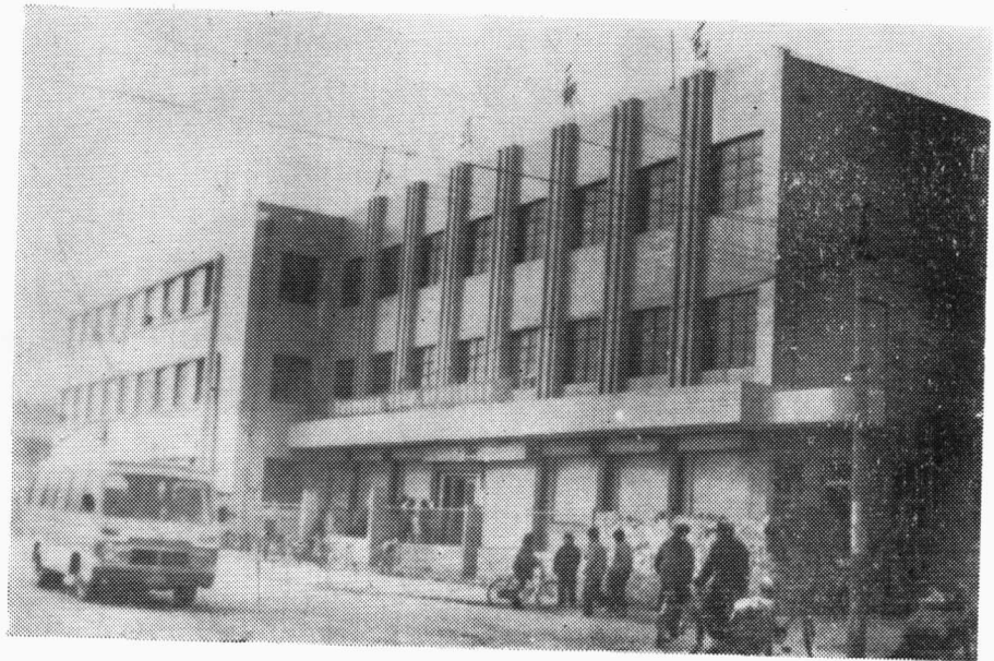
邮电营业大楼
