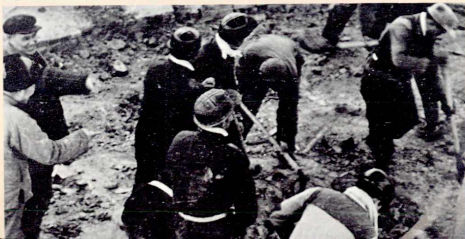
姚桥矿破土动工
