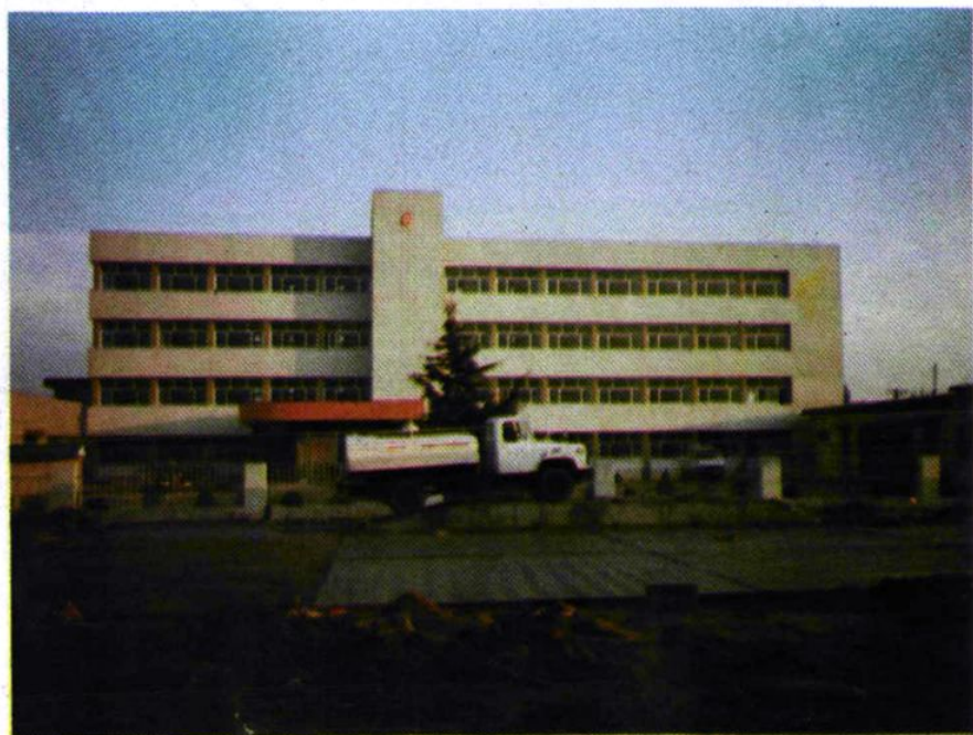
邹县公路站新建大楼
