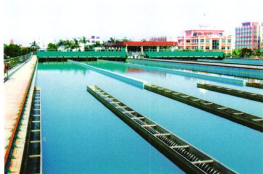
澄海市自来水公司第二水厂（沈立仁摄）
