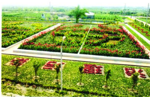
莲华镇碧砂村人工湿地污水生态处理工程（陈志伟摄）
