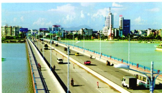
新建外砂大桥（陈 志伟摄）
