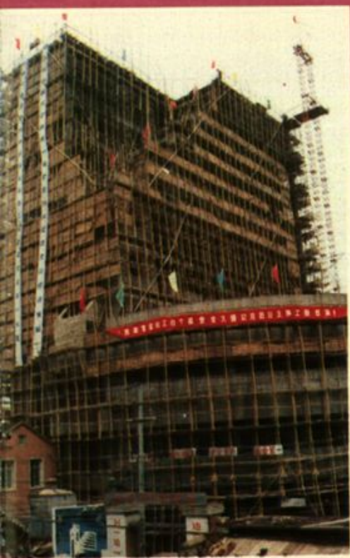
县一建公司承建的县工商行大楼
