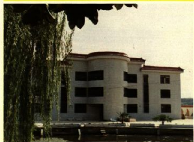
县一建公司承建的昭关宾馆小楼
