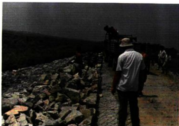
抢筑堤防护坡
