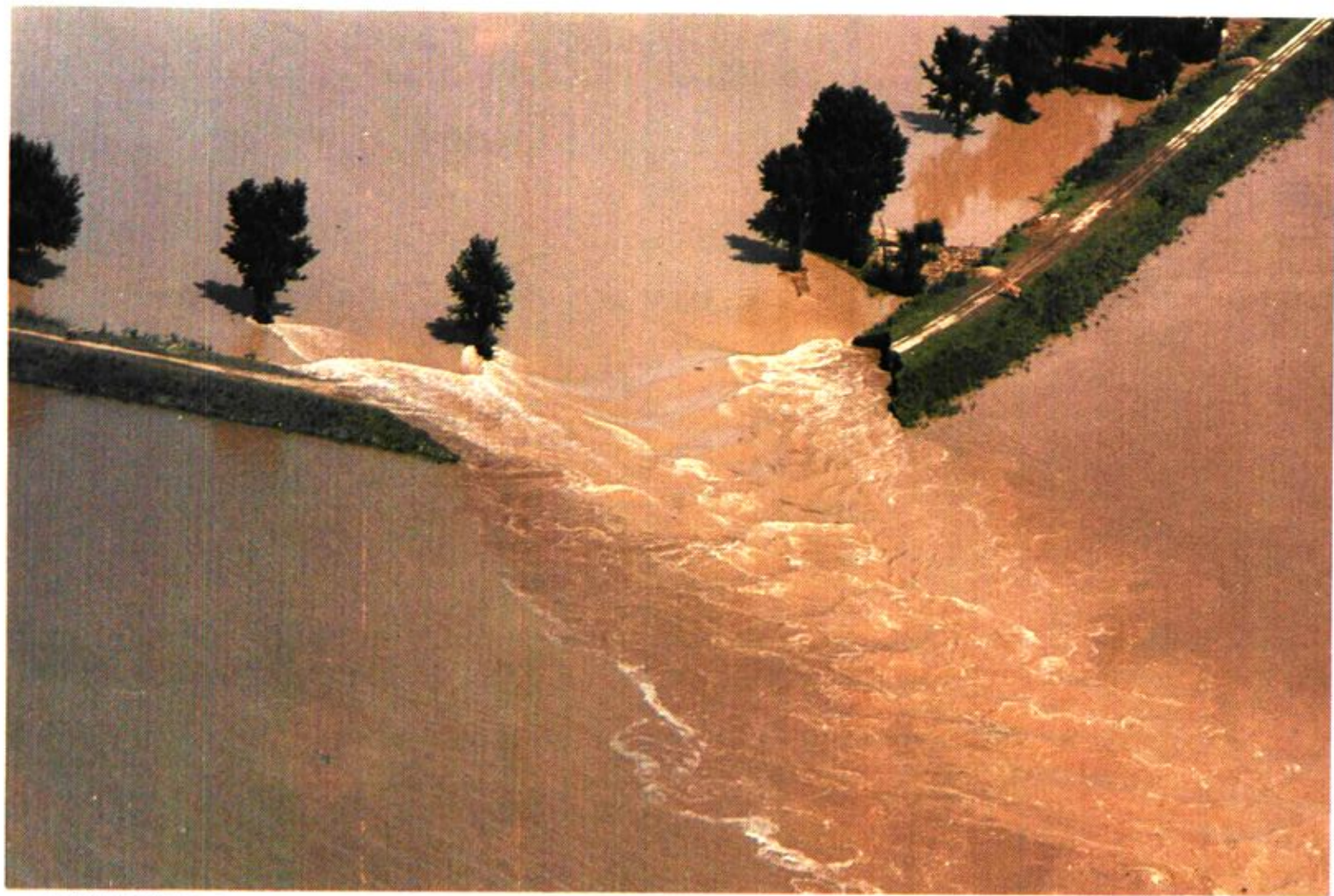
辽中县浑蒲交汇决口处
