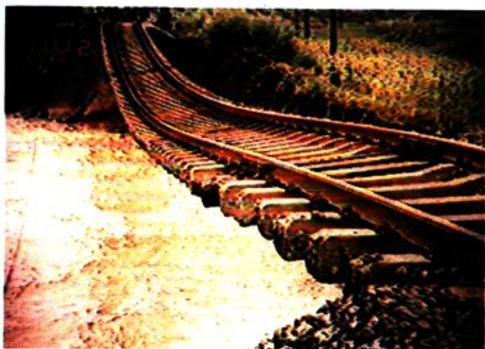
沈山铁路被冲毁
