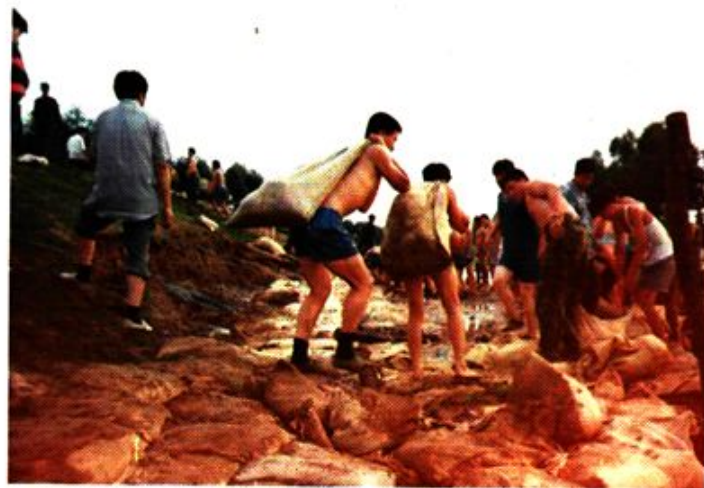
路面砌起临时屏障防止洪水进入辽中县城
