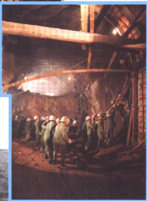
隧洞施工中喷锚支护
