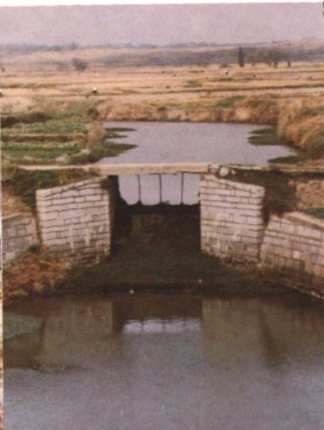
上桥小河闸(民国卅二年建)
