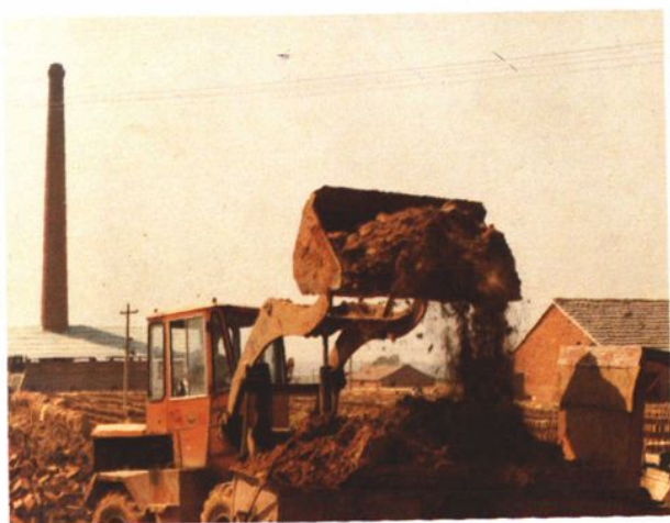
宝堰砖瓦厂机械化铲土
