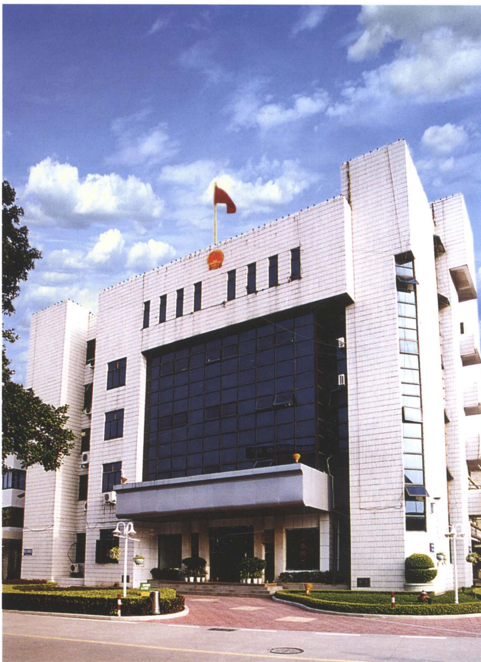
▲ 晋江市人大常委会办公大楼
