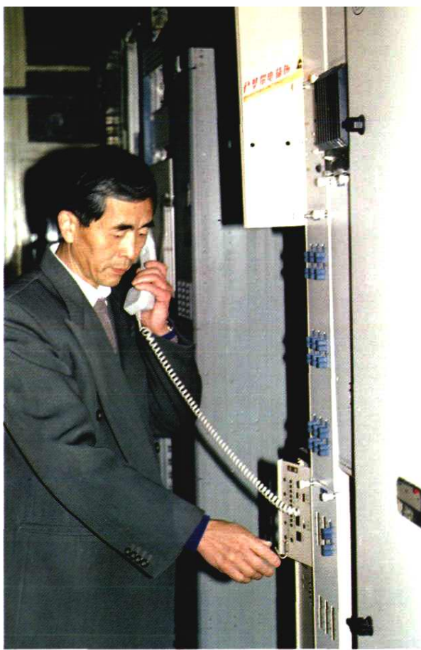
正在检测光、电中继器
