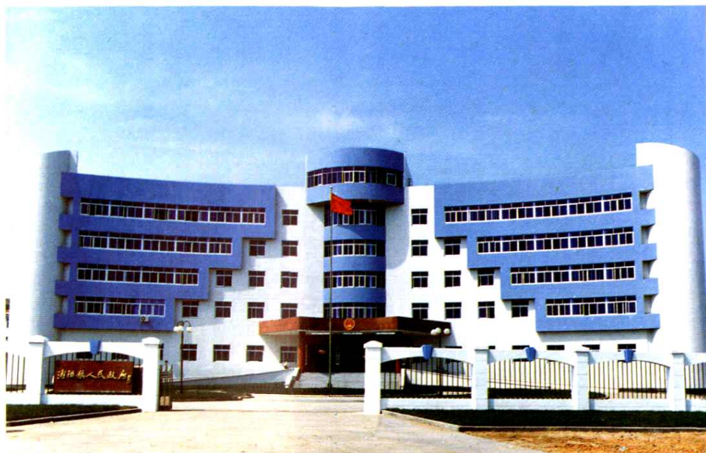
△ 浦阳镇人民政府办公楼(1996)
