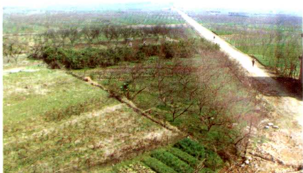
▷徐地畈小流域治理工程
