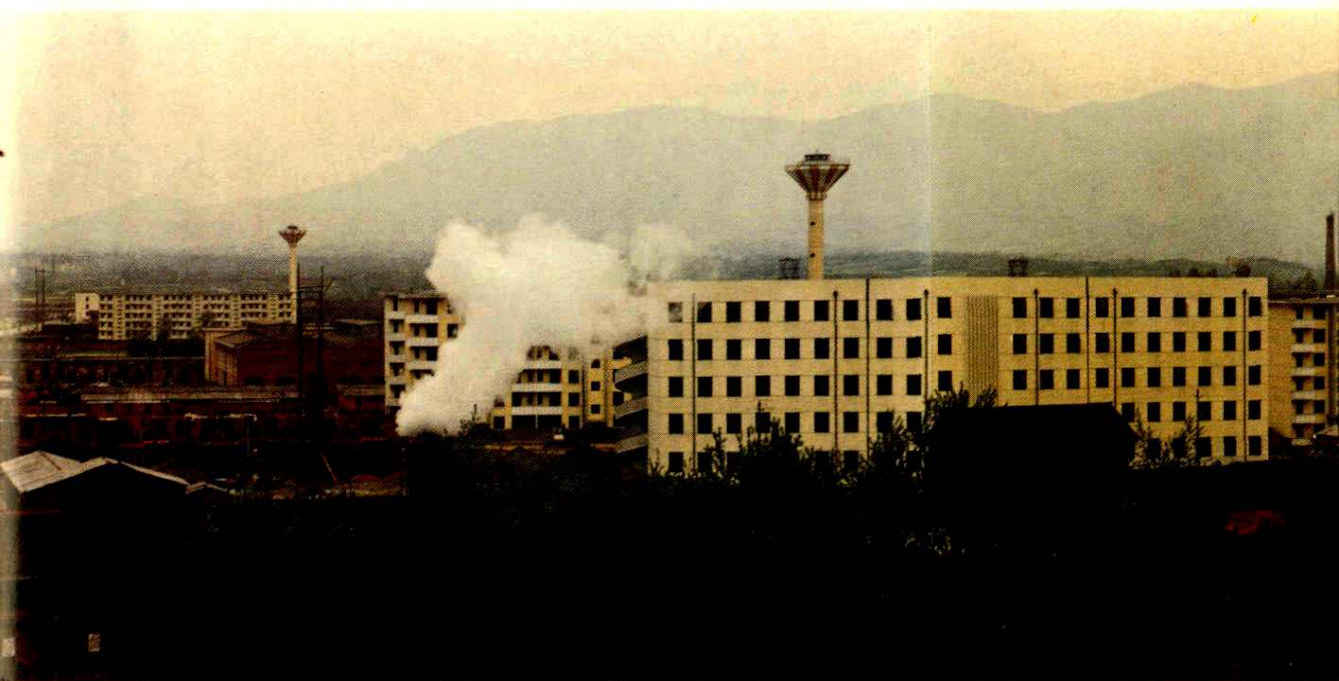
● 建设中的大河坎工业 业开发区
