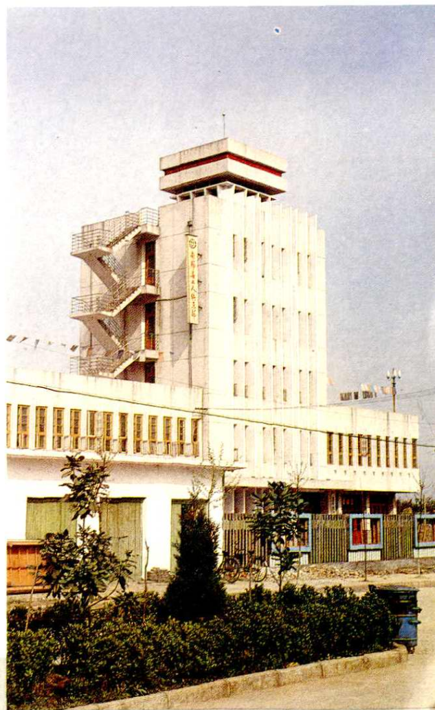
县工人俱乐部
