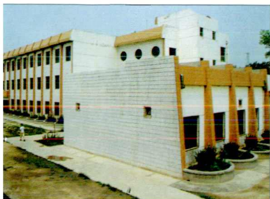
耀县中学综合实验楼
