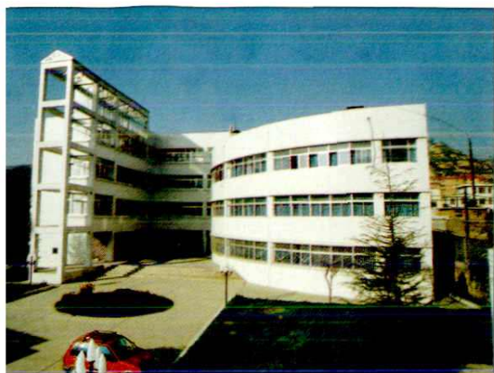
铜川师范综合实验楼
