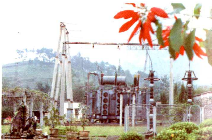
六圩变电站站区 绿化景一瞥
