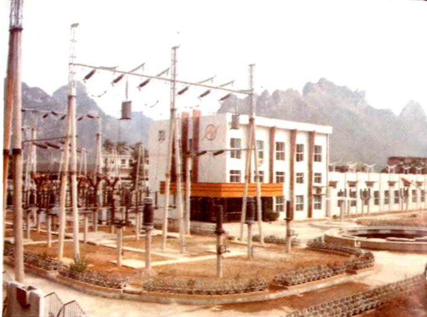
新建110千伏金城江变电站外貌
