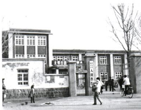
1974年建成的门诊楼
