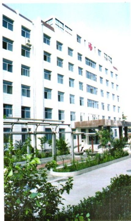
1998年建成的病房楼
