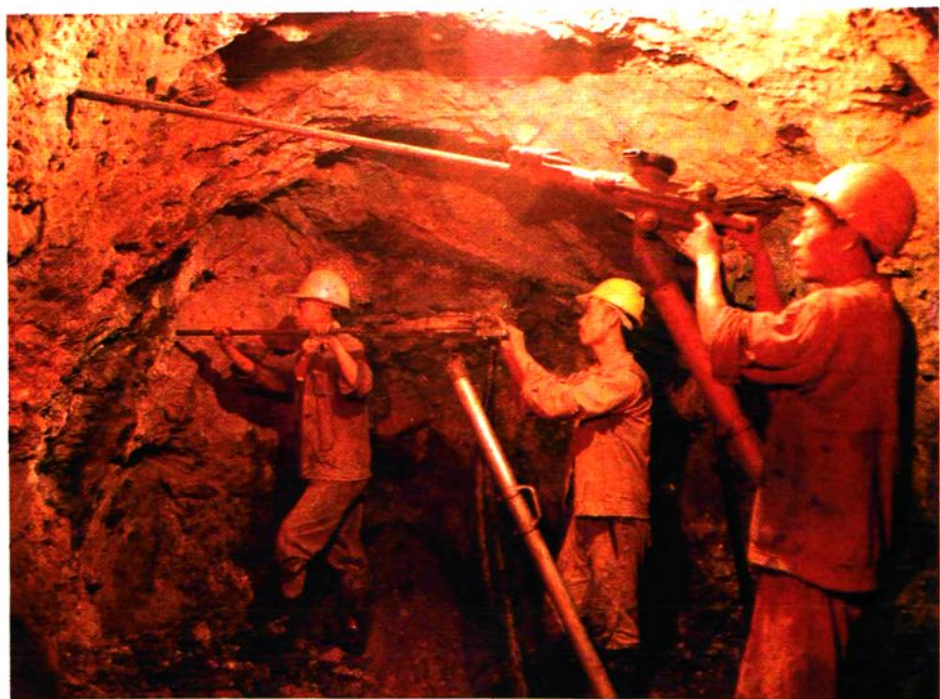
照 3 — 1 马庄矿区井下掘进工人在专心操作
