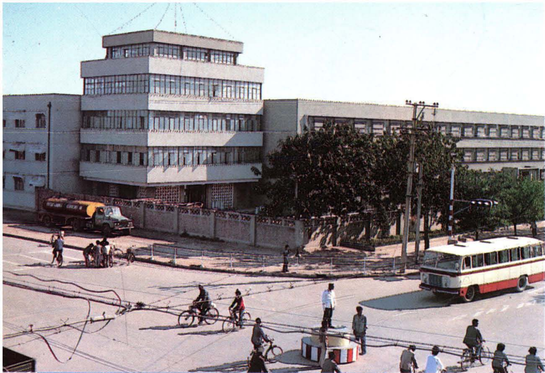
沧州地区交通局办公大楼
