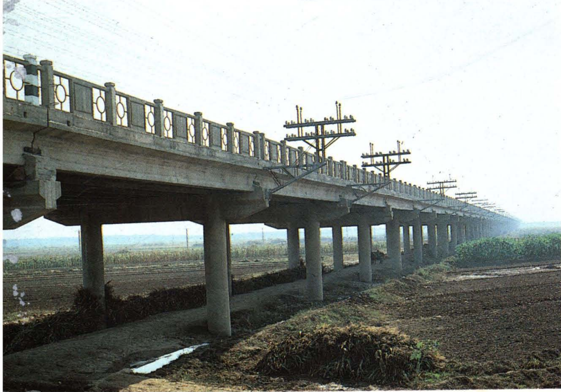
献县子牙新河公路大桥
