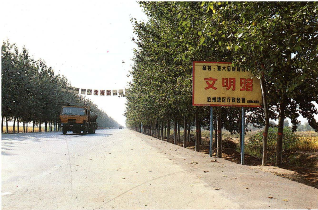
北京至大名公路河间段文明路
