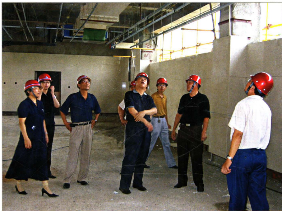
2006年7月19日，山东省档案局局长张奎明（右四）调研日照市档案馆综合楼建设情况。
