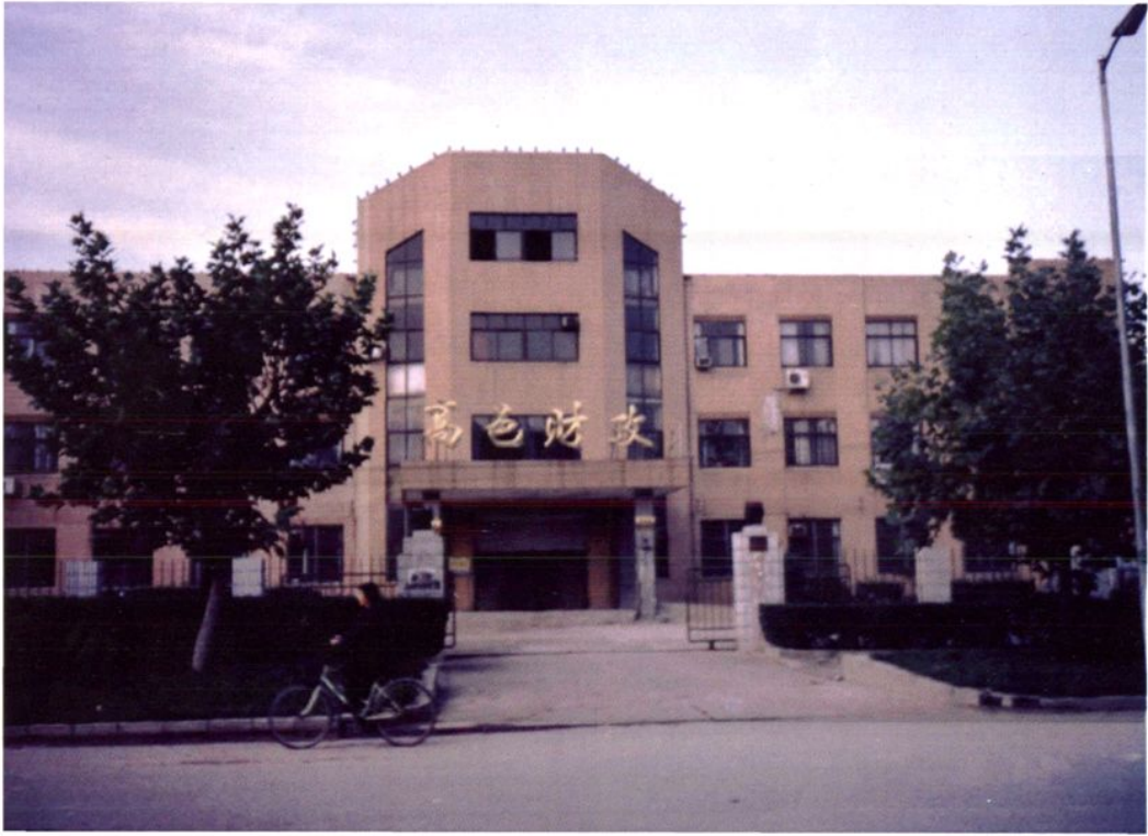
高邑县财政局办公大楼
