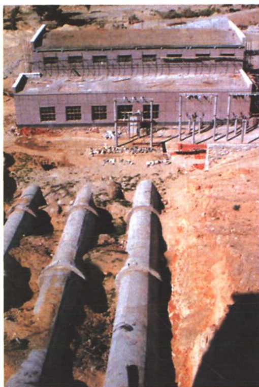
正在建设中的布尔津县托洪台水电站 (1989年9月)
