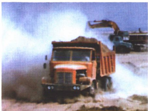
土方工程(1997年9月)
