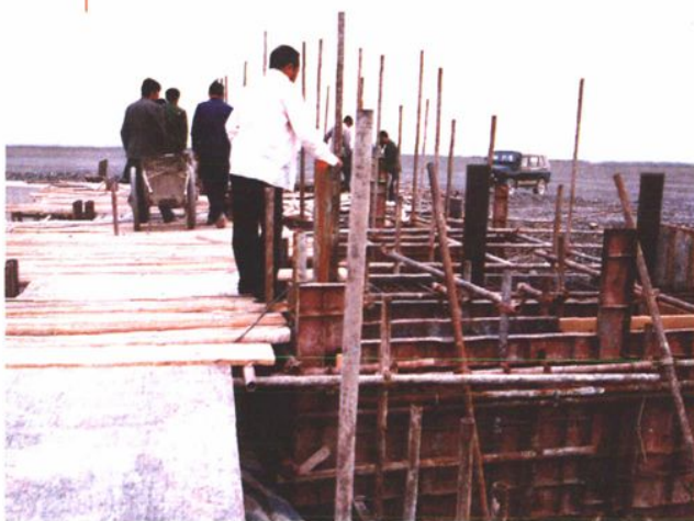
通道施工(1999年8月)
