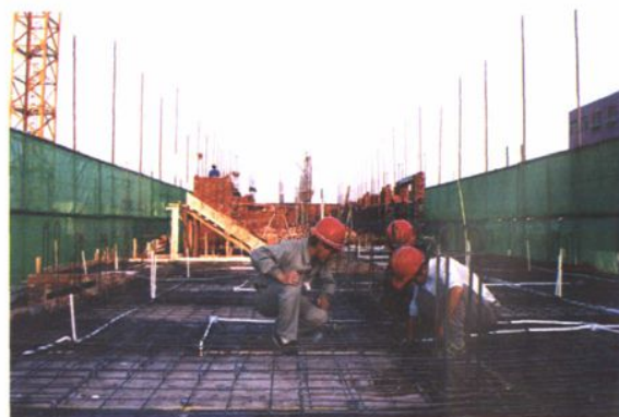
奎屯市康乐园小区38号住宅楼楼顶施工(1998年6月)
