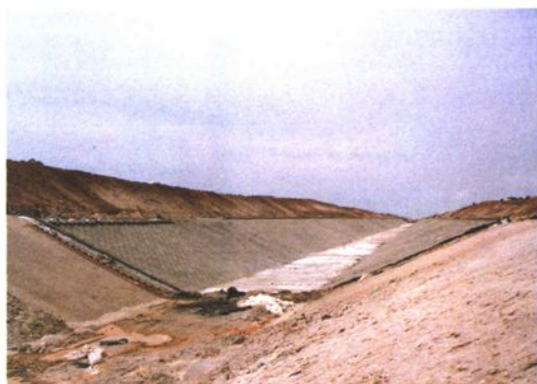
正在建设中的引水大渠(2002年9月)
