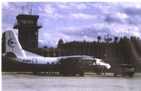
伊宁机场停机坪(1991年10月)
