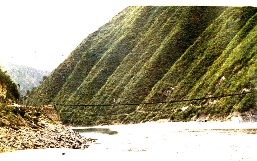
山阳县安家门 钢悬索桥
