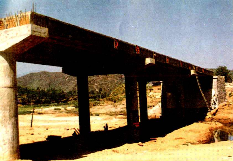
会峪桥施工现场
