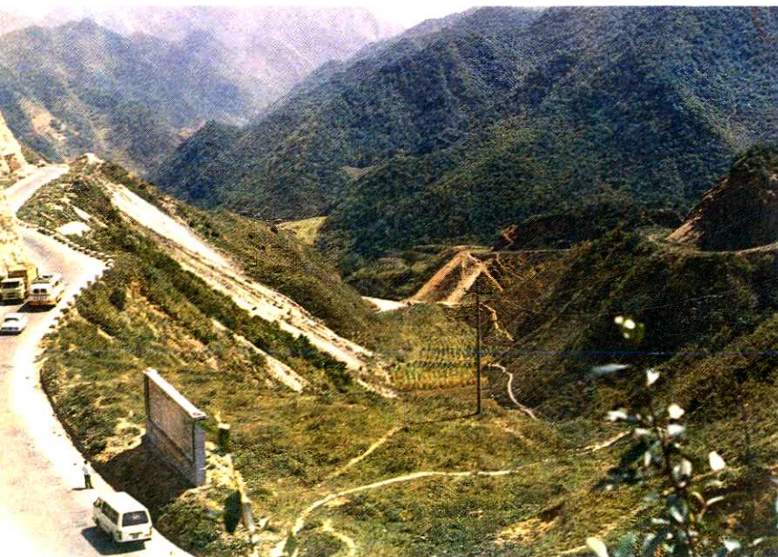
秦岭顶新旧公路(右侧为旧公路遗迹)
