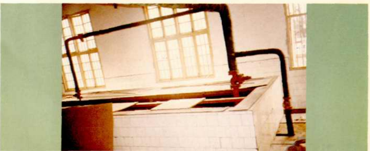
岳阳华兴食品饮料厂生产车间
